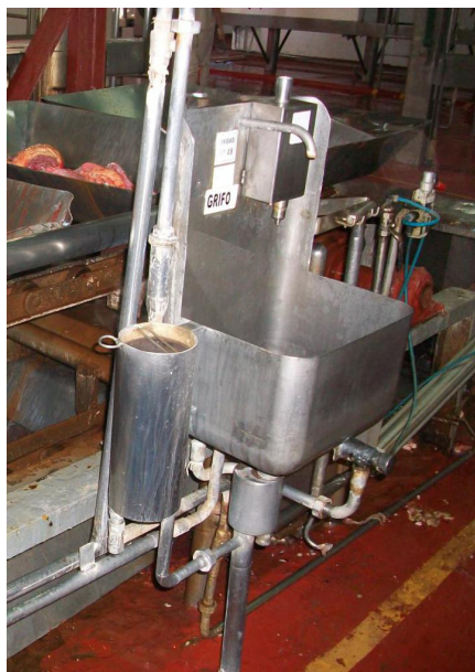
Figura 11. Esterilizador de cuchillos y lavamanos
