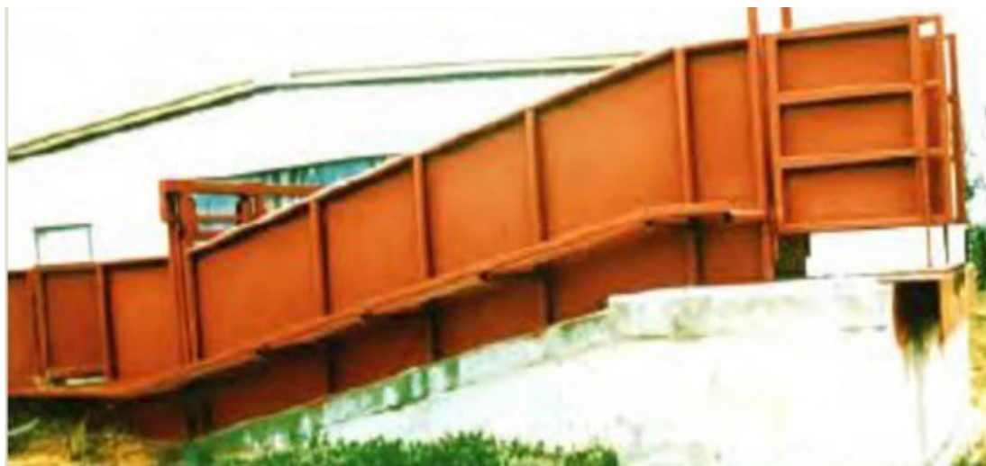
Figura 1. Rampa con pendiente adecuada
