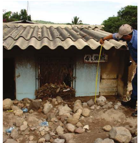
Fotografía 10. Impacto de deslizamiento en Verapaz por lluvia extrema, noviembre de 2009.
