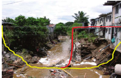
Fotografía 8. Ocupación del área de inundación del río y estrechamiento del cauce. Fuente: Bertoni.
