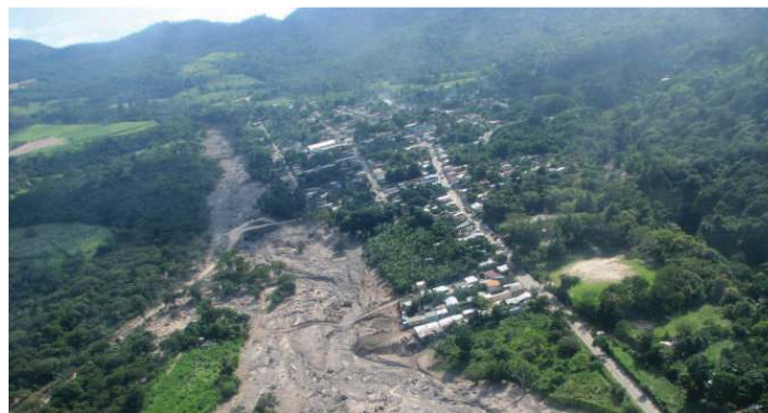
Verapaz después de deslizamiento ocasionado por lluvia extrema
