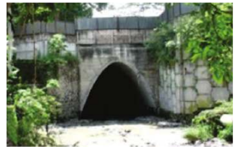
Fotografía 9. Bóveda en Arenal Monserrat estrecha el cauce de la quebrada.
